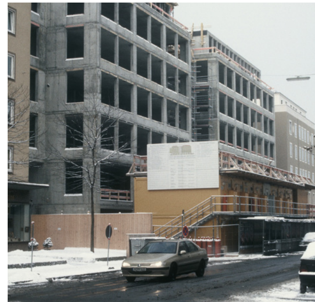
Zahlreiche Gewerke waren am Bau beteiligt. Treppenhaus im Rohbau (u. r.)
