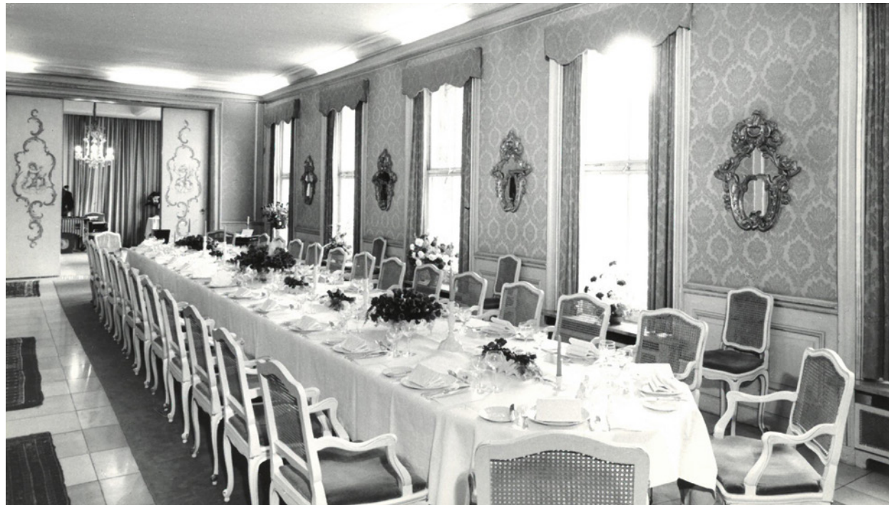
Frühstücksraum mit Blick in den Garten in den 1960er Jahren
