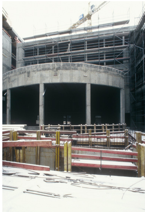
Rohbau und Fertigstellung, 1996
