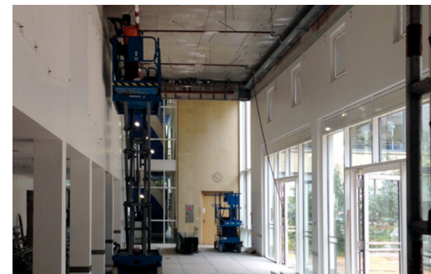
Umfangreiche Umbauten und Modernisierungsmaßnahmen im hbw, 2015
